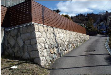
写真3 補助金を利用して改修されたブロック塀
