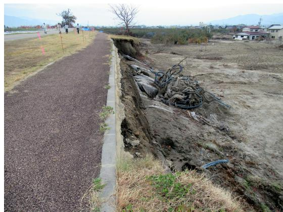
写真5 決壊場所の直上部の堤防
