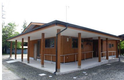
27 年度国交付金を用いて完成した「東町地区高齢者支えあい拠点施設」
