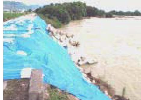
写真1：中之郷の高瀬川堤防損壊部（ビニールシートで覆われた部分）
