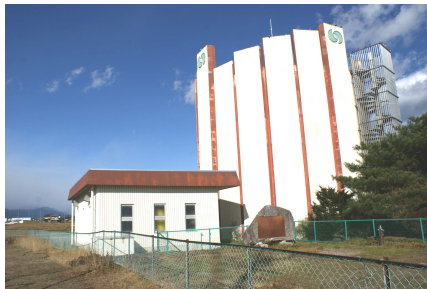
5丁目にある水道用地下水揚水第5水源：地下44mから揚水
