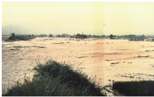
S44 高瀬川右岸北細野にて堤防決壊 左が切れた堤防（大町建設事務所）
