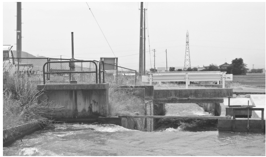
現在の正科分水口水門
